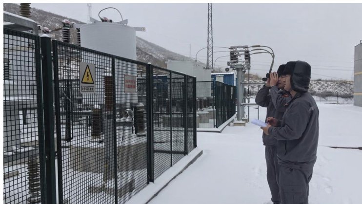
曹妃甸公司現場巡查
