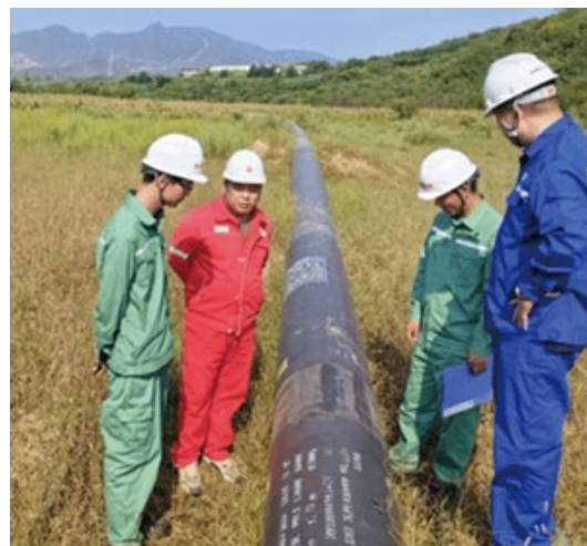
鹿泉 - 井陘輸氣管線項目
