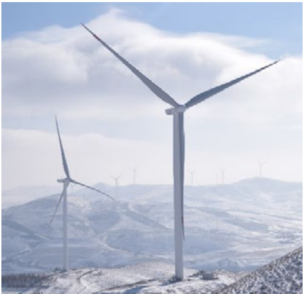
丰宁大区风电场项目风机
