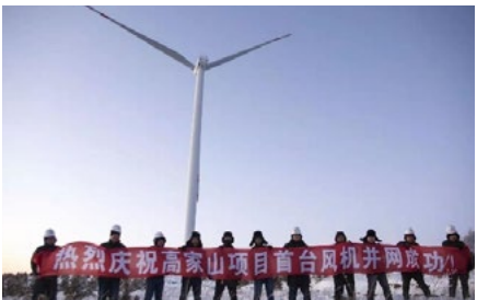
高家山项目风机并网成功现场
