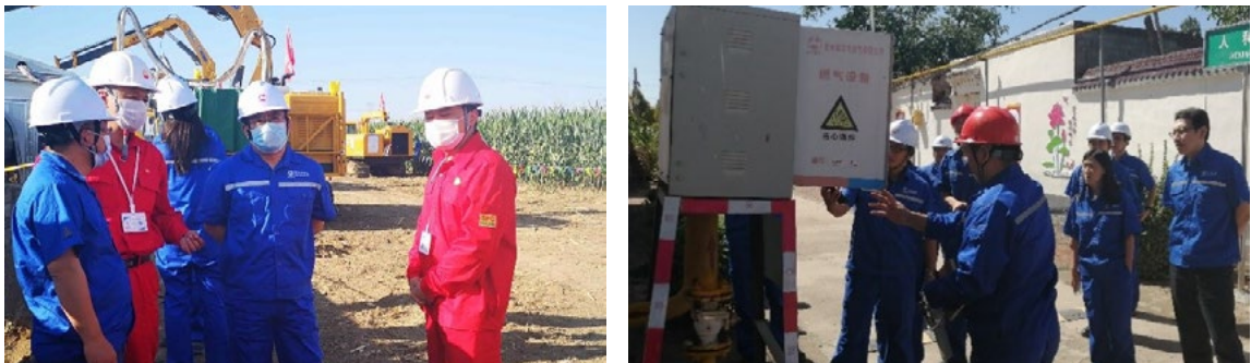
双节前综合安全生产检查现场
